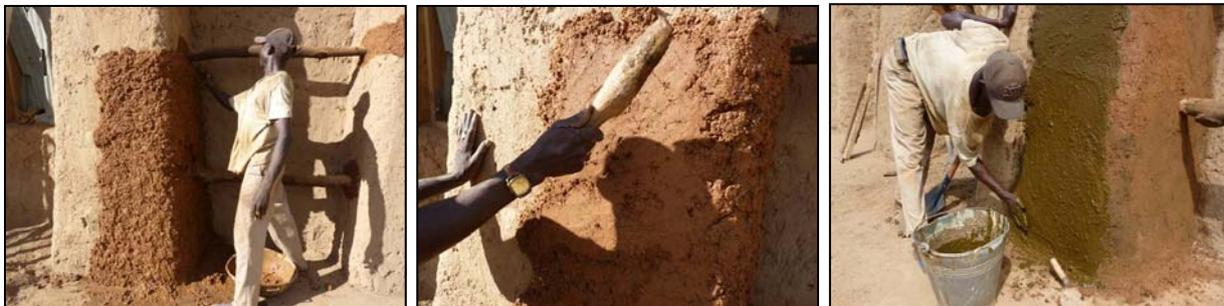
Mise en œuvre de l'enduit : pose, frappe et badigeon de bouse de vache. © Sébastien Moriset/CRAterre-ENSAG
